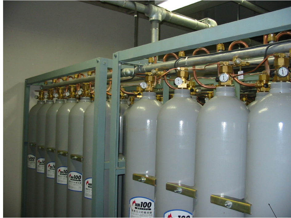
窒素ガスポンベ
