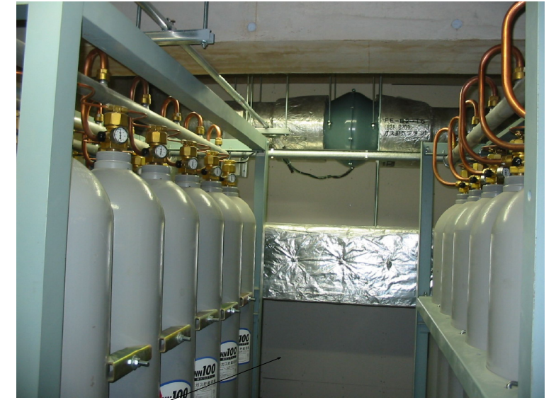
窒素ガスポンベ
