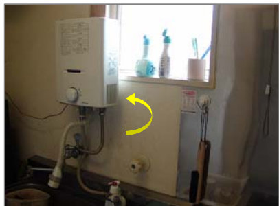
湯沸し器裏石綿含有けい酸カルシウム板 (湯沸かし器の裏やガスレンジの下は熱くなるので断熱のために使用)
