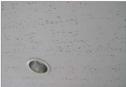
岩綿吸音板 (一般的な建物の天井に使用)
