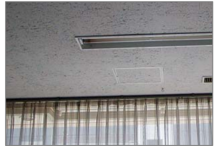
岩綿吸音板 (一般的な建物の天井に使用)
