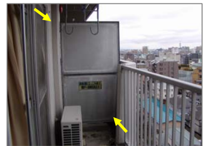
フレキシブル板 (マンション等のベランダで「非常時の場合はこの壁を破って・・・」と書いてある板)
