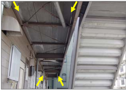
中空 押し出し成形板 (床の耐力板)
