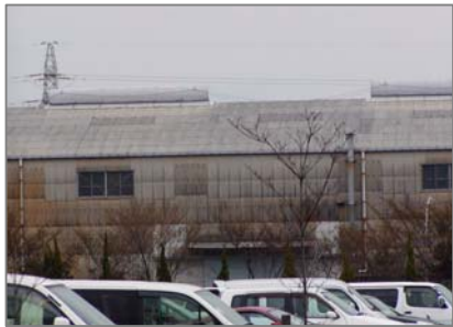
工場・倉庫などの屋根・壁
