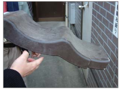
板金屋根上乘せ石綿屋根材
