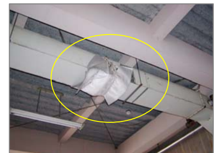
石綿保温材(石綿ふとん)
