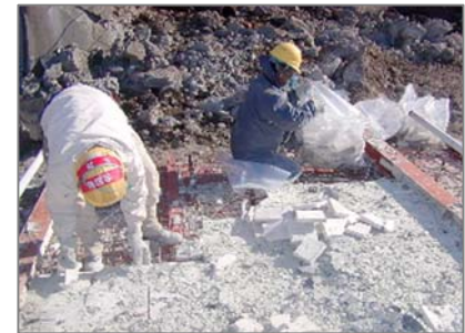
炉の保温材の撤去、回収作業 (もろいため、粉状になっています)
