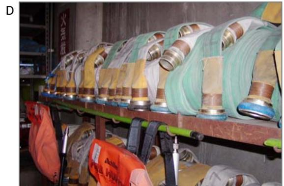
ホースも高圧の水力に破れないように金線や石綿が入っているものもありました。同じくビル内の廊下の壁などに収納されている消火栓箱も裏面などは耐火構造になっています。これらの石綿含有の耐火製品や耐火物が劣化・損傷等することにより、飛散した石綿にはばく露する可能性があります。
