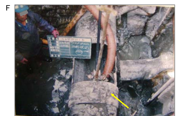
③ 水道管の集積。尚、石綿セメント管という標記は上下水道用、石綿セメント円筒という標記は煙突など建築用に用います。
