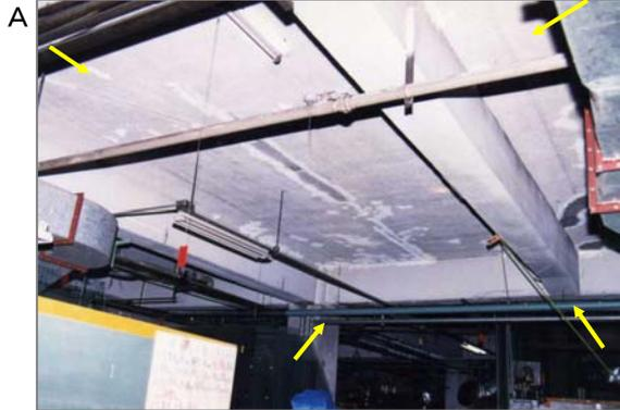
【作業環境】ガラス製造工場は高熱作業があり、設備・装置機器への保温材・断熱材・絶縁材等はかかせません。写真は加熱炉が設置されている建物の天井断熱材としての吹きつけ石綿。
