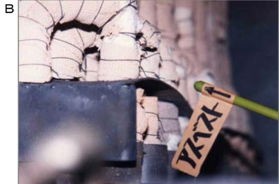
加熱炉スポットバーナーガス管に巻かれた石綿テープ。ガスを熱源とする連続加熱炉は、ガスが配管内でバックファイヤーして配管が溶断爆発しないように、石綿テープを巻きました。修理・交換時に石綿にばく露する可能性があります。
