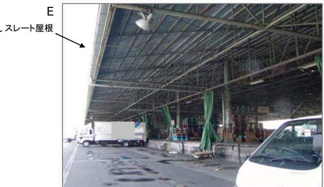
E 物流基地。石綿含有商品をフォークリフトで積み替える時に破損などが皆無とはいき切れません。トラックターミナルに多く使用されるスレート屋根の劣化によるばく露の可能性もあります。
