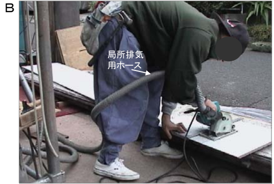
B 日本家屋の新築で、外壁の石綿含有サイディングを、サイディング工が丸鋸で切断しています。最近の作業で局所排気用のホースが見られます。
