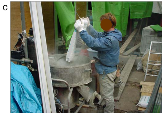
C 民家の新築作業で、左官工がセメントにモルタルを投入している作業で、投入時に粉じんが発生します。モルタルには、石綿含有製品もありました。
