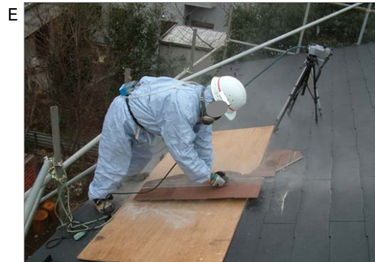
E 屋根工が、屋根用の石綿含有化粧板を切断する作業を行っています。多くの屋根材に、石綿が使用されていました。
