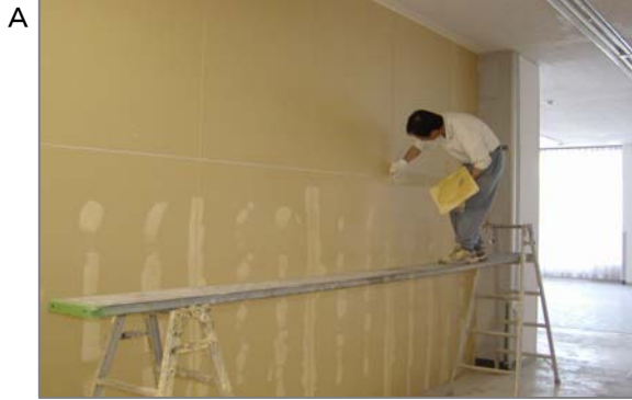
リフォームの主な壁紙の張替え(クロス工)。下地調整が最重要でパテ(目止め)で何回もしごきます。昔はこのパテに石綿混和材が、またごく一部ですが壁紙にも混入されていました。
