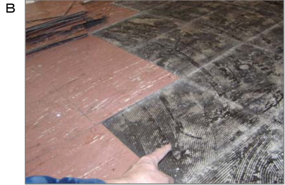
床の石綿含有ビニル床タイルは重歩行度や温湿度、経年などで劣化(剥れ、浮き、磨耗など)します。この黒い接着剤にも石綿は混入しています。張替えはこの接着剤をキレイにサンダー掛しますが、その際に石綿にばく露する可能性があります。
