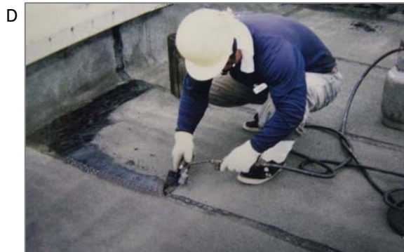
屋上での修理作業。屋根材に石綿が含有していることもあり、漏水箇所を切り開いて修理する際に石綿が飛散することがあります。写真はアスファルトフェルトの補修作業(一部、石綿含有品あり)。
