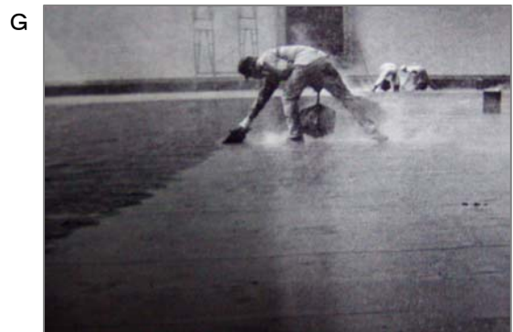
③最後のタールを上塗りしているところ。打ち粉として微少な石綿をふっていたかもしれませんが確認できていません。このあとの時代は、石綿とは関連のないシート防水が主流になりました。
