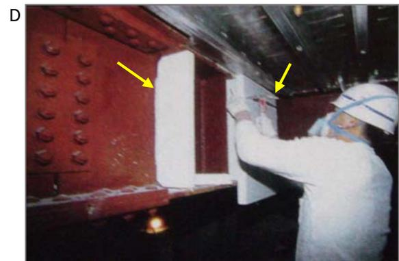
D 左と類似していますが、主材が白石綿+ケイ酸カルシウムで出来たキレイな白い表面のボード。柱にも使えます。現場での寸法合わせでの切断は多量の粉じんを発生させてしまいます。
