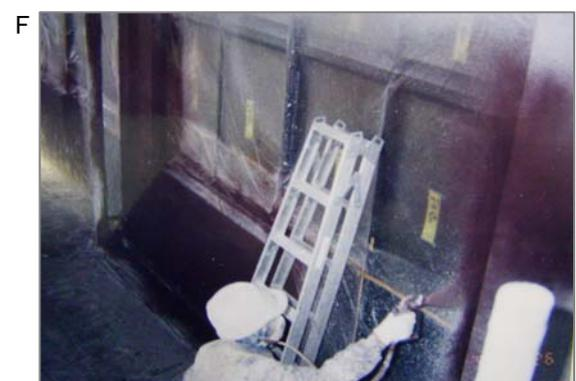
F 塗装(ガン吹き)工事。塗料には顔料、沈降防止剤、増量剤、流動性増進剤などの目的で白石綿混入のタルクがはいつていました。
