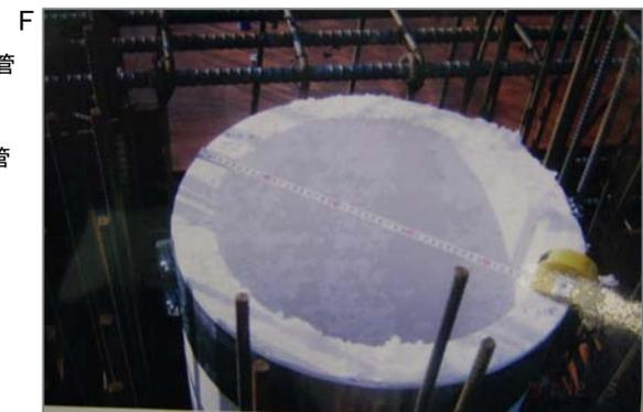
F 煙突ライニング材。写真はノンアス品。従前は茶石綿の高含有品を使用。多くのビルで採用していました。煙突内の上昇気流(ドラフト)で若干、繊維が大気に放出され作業員がばく露する可能性があります。
