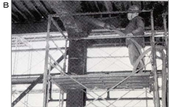
B 鉄骨建て方・床・屋根が出来ると耐火工事が始まります。吹きつけ機を用いて石綿の吹きつけがおこなわれていました。
