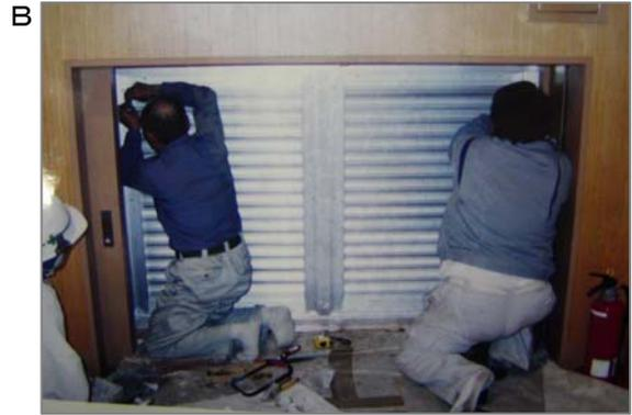
B サッシ工事(金属建具工事)。写真では判りづらいのですが内壁などに吹つけられている石綿を少し掻きとって鉄骨面から補強のリブ(カ骨)などを入れる箇所があります。
