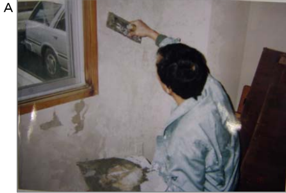
A 左官工事の壁下地調整。この後に塗装したり壁紙を貼ったりの作業があります。これらの下地用接着剤等に不純物としての石綿が入っていた可能性があります。
