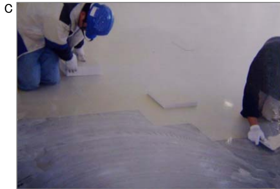
C タイル工(Pタイルは商品名で一般名称はビニールアスベストタイル、縮めてビニアスタイルと呼ぶ)。昭和の時代は全て白石綿が高含有。このタイル張りの接着剤にも石綿が含有されており、修理、解体時にばく露の可能性がります。
