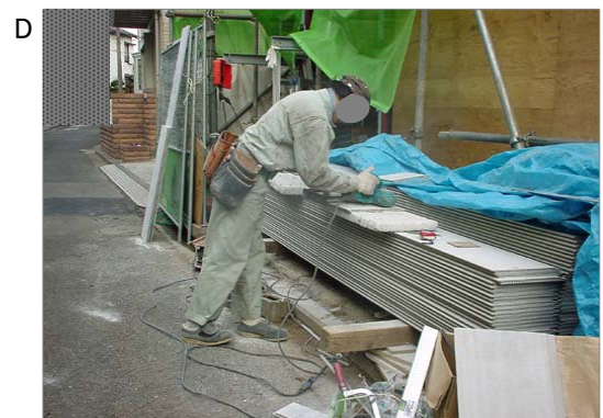
D 新築時の外壁の石綿含有サイディングを切断する作業です。1970年代は大工職がサイディングの切断をする事も多かったようです。
