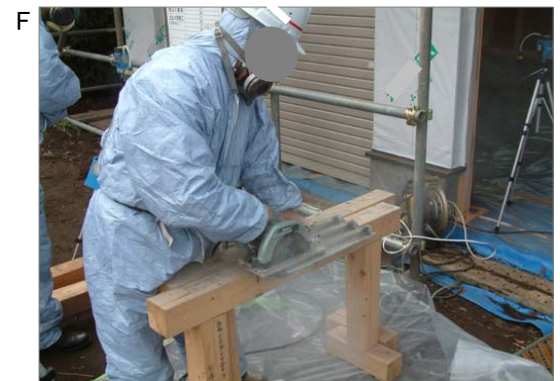
F 屋根工が、石綿含有の波型スレートを切断する作業です。屋根材、壁材、床材等、建築現場には石綿含有製品が多く、このように現場で切断作業を行うことにより、現場で粉じんが発生します。
