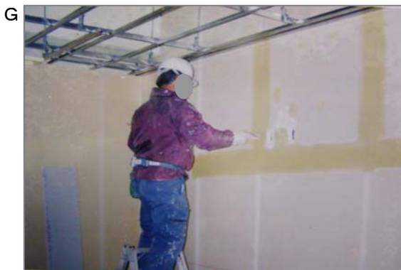
G クロス工。下地の石膏ボード(石綿含有時期あり)の継ぎ目にパテしごきします。パテ(石綿含有は未確認)は乾燥により痩せるので何度も丁寧にかけます。
