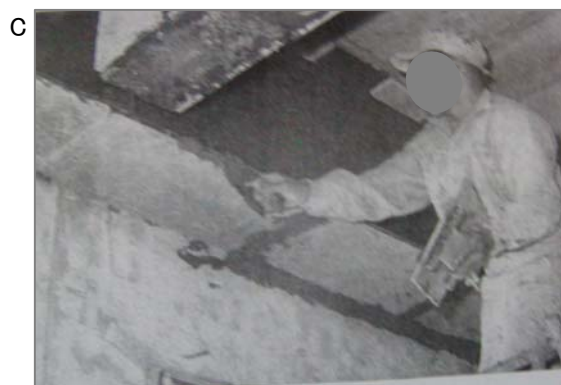
C 吹きつけとは別の工法で茶石綿で出来た石綿耐火被覆板の張り工事。クギ、カスガイおよび石綿含有耐熱接着剤で留めます。昭和45年前後の工法で、吹きつけに比べればばく露量は少ないですが、現場で切断加工する際には粉じんが発生しました。
