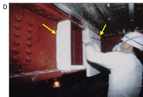
D 左と類似していますが、主材が白石綿+ケイ酸カルシウムで出来たキレイな白い表面のボード。柱にも使えます。現場での寸法合わせでの切断は多量の粉じんを発生させてしまいます。
