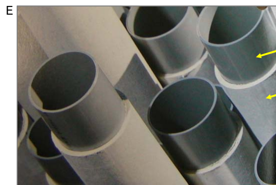
E 建物内の給排水用パイプ、石綿セメントビニル管。室内との温度差によるパイプ表面の結露防止対策として、内側は流水し易い塩ビ管にして外皮に石綿管を断熱材としていました。破損や修理時にばく露の可能性があります。
