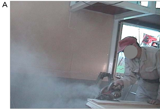
A 日本家屋の新築(街場 まちば)作業で、大工職が石綿非含有の石膏ボードを丸鋸(のこ)で切断しています。石綿含有の場合にも、同様に多量の粉じんが飛散したことが想像されます。
