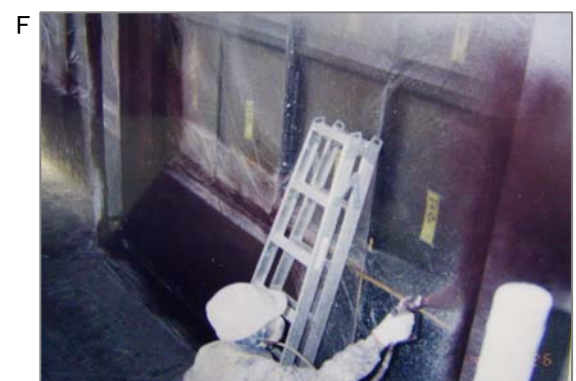
F 塗装(ガン吹き)工事。塗料には顔料、沈降防止剤、増量剤、流動性増進剤などの目的で白石綿混入のタルクがはっていました。
