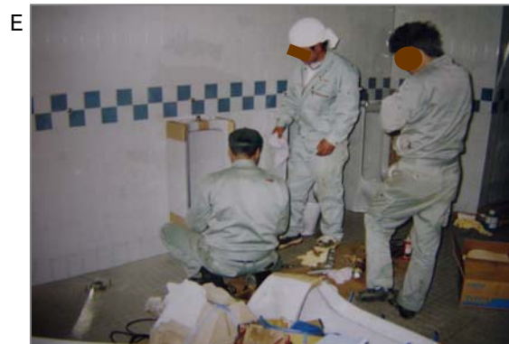
E トイレ取付けなどを給排水設備工事(衛生工事)といいます。石綿セメント板や石綿化粧タイル板の壁に穴を開けたり、カットしたりするため、石綿ばく露が皆無とは言い切れません。
