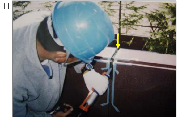
H シーリング(ローキング)作業。継ぎ目や隙間、クラック部などに充填します。以前のコーキング材にはかなりの含有率で石綿が入っていました。劣化するとボロボロになるものもあります。
