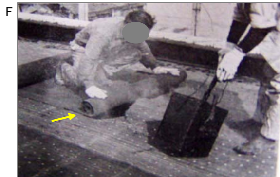
②昭和30年代の屋根の防水工事。アスファルトフェルト(巻物)を押し広げ、重なり部分に解かしたアスファルト(増粘剤として石綿を混ぜることあり)を流し込みます。非常に“熱い作業”なので石綿製の手袋等を使用することもありました。
