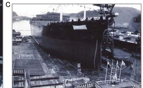
C ③進水。1959年。船はドックから進水し岸壁で船内の他の整備(ぎ装)が続きます。
