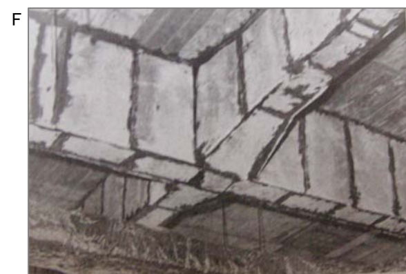
左の石綿耐火被覆板を梁に貼ったところ。釘・かすがい・接着剤(石綿入り)で施工しました。収まりを良くするために、現場で材料を形に合わせて切断することは必要な作業ですが、吹きつけ工法よりは粉じんの発生は少ないです。
