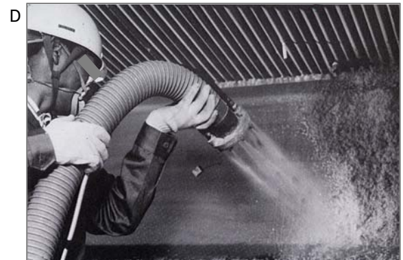
写真は最近の岩綿吹きつけ(石綿は含まれていません)。仕組みは昔と変わらずホースの中央より綿が出て、その周囲の数箇所のノズルより霧状に水の圧力で対象物に付着させます。昔と較べて粉じんは少ないです。
