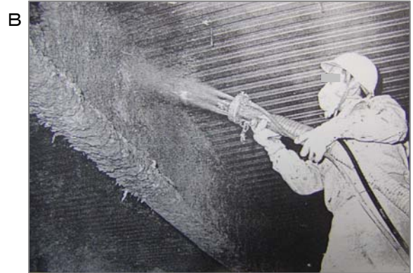
鉄骨の梁(はり)に耐火被覆として吹きつけているところです。この作業周辺は粉じんが舞っていて、作業者や周辺で作業をしていた者が高濃度ばく露した可能性があります。
