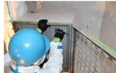
②HEPAフィルタの装着後装置を稼働させ、スモークテスターを用いて側面からの吸い込みがないかを確認する。必要に応じて、HEPAフィルタ面をシート等で塞いだうえ、スモークテスターでの吸い込みを確認する。
