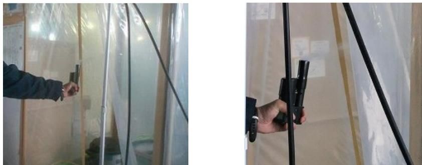
図-19 セキュリティーゾーンの入口の気流方向の確認
