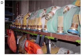
ホースも高圧の水力に破れないように金線や石綿が入っているものもありました。同じくビル内の廊下の壁などに収納されている消火栓箱も裏面などは耐火構造になっています。これらの石綿含有の耐火製品や耐火物が劣化・損傷等することにより、飛散した石綿にばく露する可能性があります。
