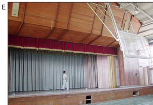
E 学校などの講堂・体育館にはかつて相当数の吹きつけ石綿がありました。ボールをぶつけるなどで石綿が飛散する可能性があり、施設管理者等が長期にわたりばく露した可能性があります。
