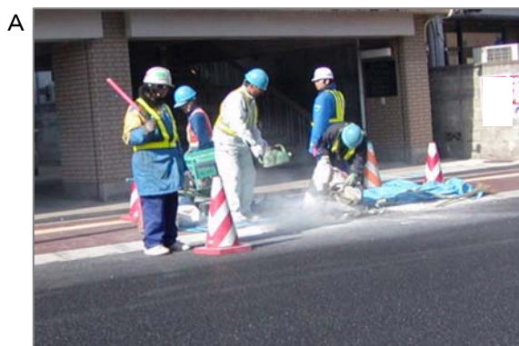
道路工事、補修作業時には粉じんが発生します。アスファルトにかつて石綿が混入していた区間においては、石綿粉じんにはばく露する可能性があります。
