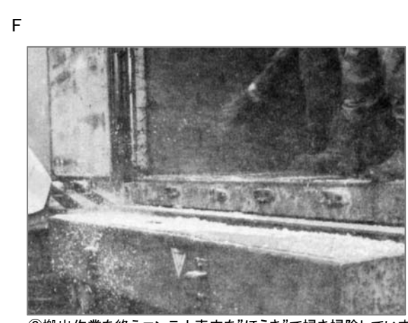
⑥搬出作業を終えコンテナ車内を「ほうき」で掃き掃除しています。車内でこぼれた石綿を掃き掃除した際には、大量に粉じんが飛散してしまいます。
