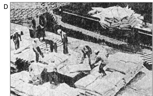
④1978年。「はしけ」から陸揚げされた石綿をパレットに積み替える作業。このときも、手鉤を使用しています。
