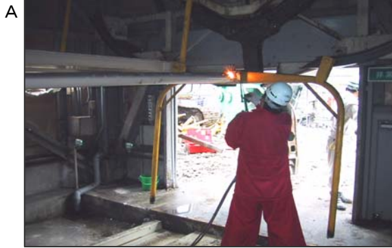
A 立体駐車場の解体作業。内部に耐火被覆吹きつけがあり、外壁は石綿含有ボードが使用されていました。解体には順序があり、まずは有害な石綿含有部分の撤去からです。
