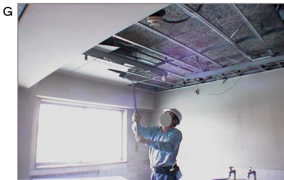
G パールを使用して天井のフレキシブル板を破碎しているところです。フレキシブル板に石綿が含有している場合に、作業者がばく露する可能性があります。
