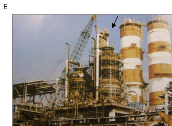
E 石油精製工場のプラント老朽化による解体工事。手順としては、石綿断熱材などの有害物質が飛散ないように、シートで覆った空間の中で撤去してから、重機で解体します。
