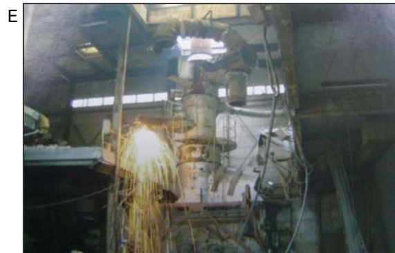
E プラント屋内の装置解体風景。高度成長期に新設された装置類(石綿保温材を多用)が更新の時期を迎えています。解体・除去時にばく露する可能性があります。
