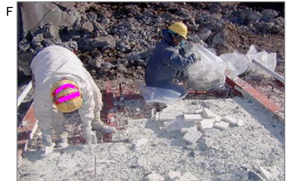
F 高熱のかかる炉などの保温材は傷みが早く定期的に修理(全取替えなど)を行います。石綿含有の保温材は軽く、破損すると飛散しやすいので非常に危険です。
