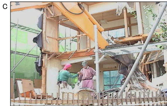
C 民家の解体。以前は、石綿含有屋根材や外壁の石綿含有サイディング材等を事前に取り除くことなく、まとめて解体していました。解体時に発生する石綿含有粉じんにはばく露した可能性があります。
