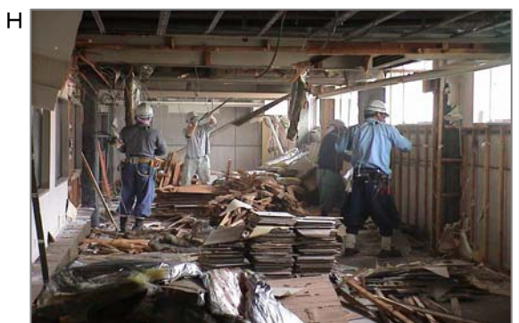
H 解体作業には石綿含有建材からのばく露の危険を伴います。今後、解体や改修工事は、建物の耐震化促進や老朽化した設備機器の取替えなど、相当数になることが予想されます。
