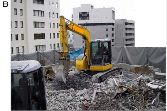
B 屋上に重機を乗せてからのビル解体作業。解体建物の外周部にはその階より高くシートを張ります。建材に石綿が含有している場合には、建材の破碎により現場の作業員が石綿粉じんにはばく露する可能性があります。
