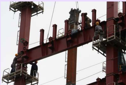
鉄骨建方風景
