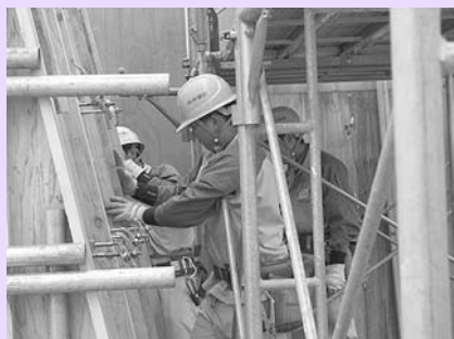
型枠組立訓練
