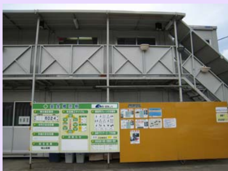
作業所の安全掲示板
