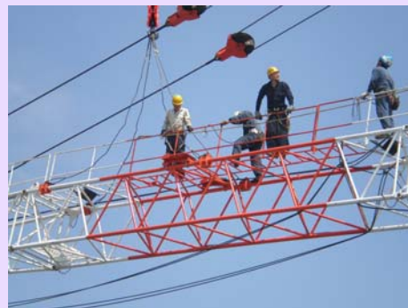
タワークレーンの組立て
