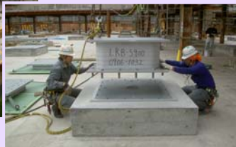
免震装置のセット状況
