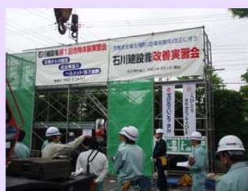
足場からの墜落実験
