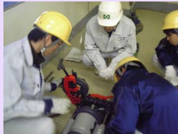
保全研修(パイプカッター)
