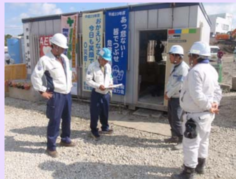
協力業者による安全パトロール
