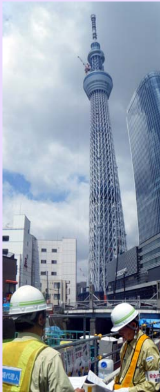
京成橋耐震補強工事の役員パトロール (右端は社長)
