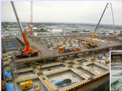
国保旭中央病院新本館建設現場
