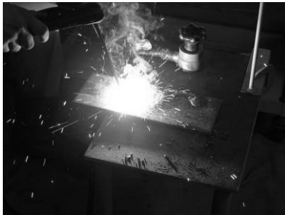
溶接ヒューム
