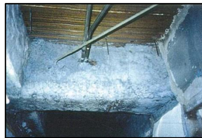
石綿による鉄骨の耐火被覆※12
