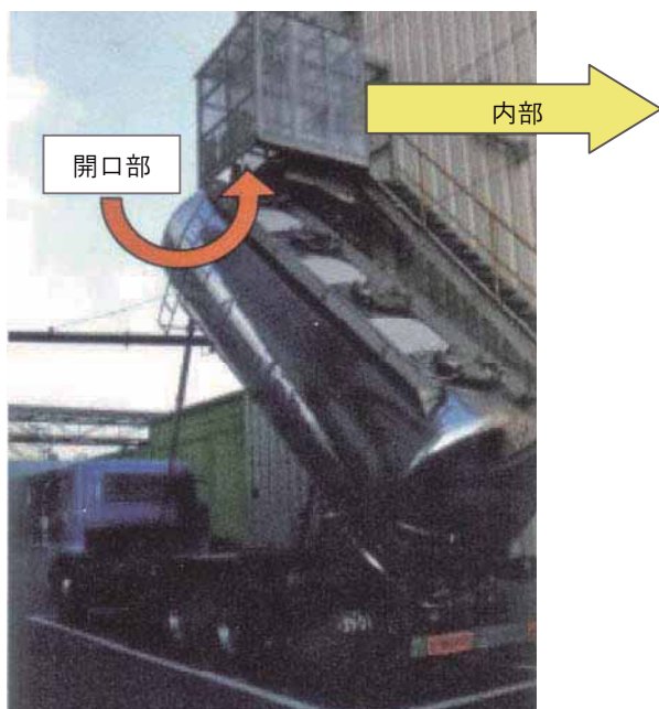
図 4-29 タンクローリーでの作業の様子
