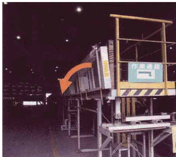
図 4-28 作業床を使用する前
