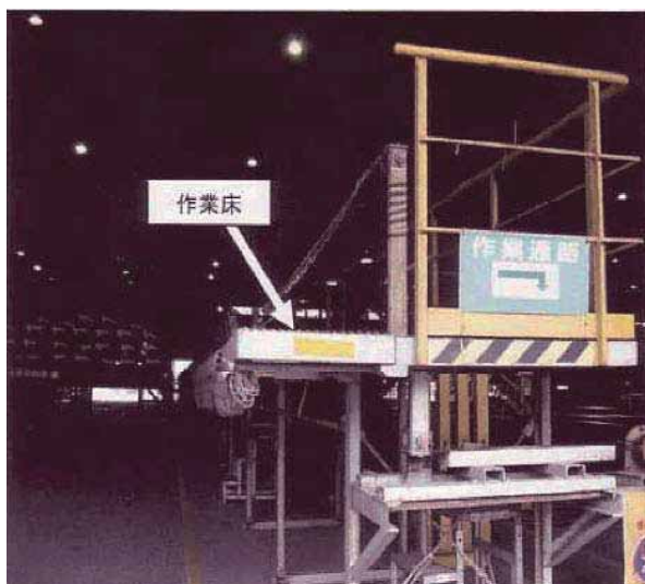
図 4-27 作業床を使用
