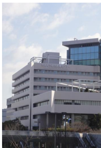
(同医療センターの外観)
