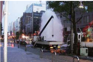
[ 街中での漏水事故 ]
