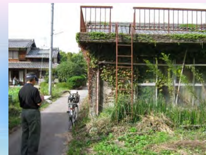
【京都府木津川市】 空き家・廃屋調査
