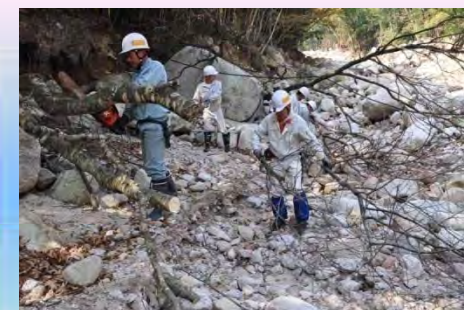
【三重県菰野町】 散策路の整備
