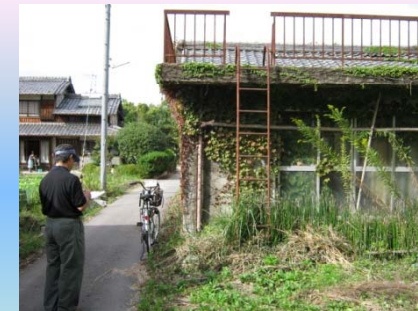
【京都府木津川市】 空き家・廃屋調査
