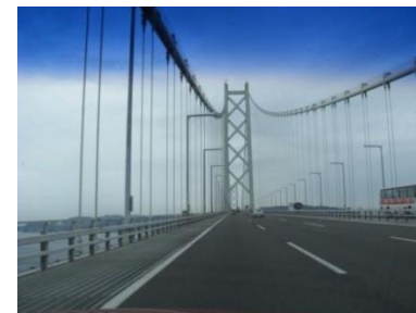
明石海峡大橋
