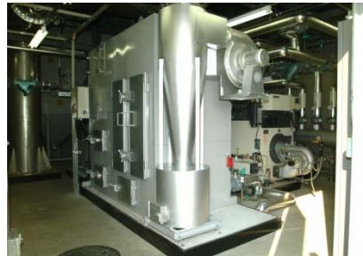
足寄町庁舎木質ペレットボイラー
