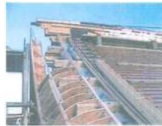
成田山川越別院改修工事(屋根部分)
