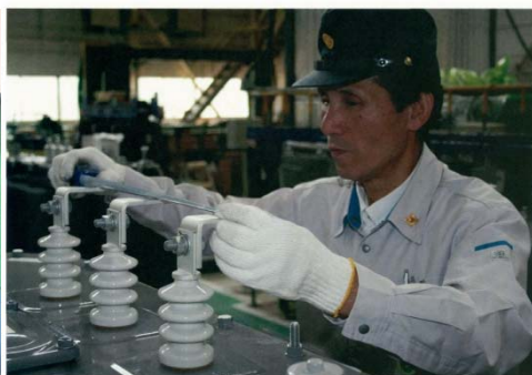
変圧器の組立作業
