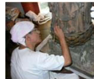
古色の修整作業
