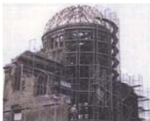
原爆ドーム改修工事
