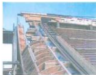
成田山川越別院改修工事(屋根部分)
