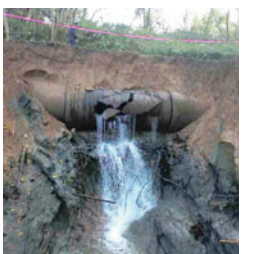
▲ 水道管の破損による土砂流出
