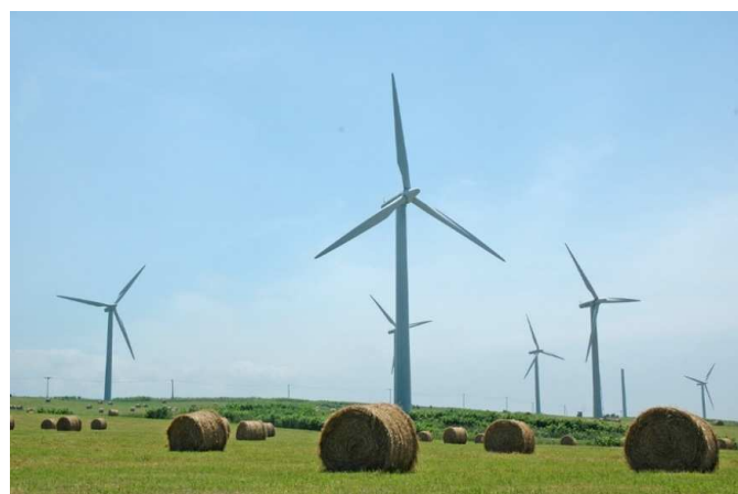
○牧草地の中に林立する風車群。風車の向きは、風況調査に基づきバラバラになっています。
