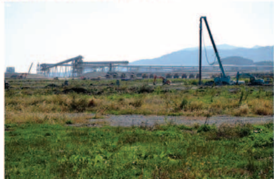
巨大なベルトコンベアによって、急ピッチで市街地の土盛りが進む。
