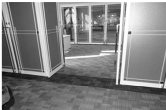
写真 11 : フラット② (入口)
