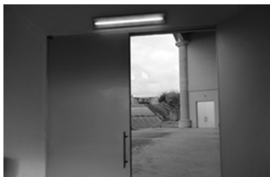
写真 6 : フラット① (舞台入口)
