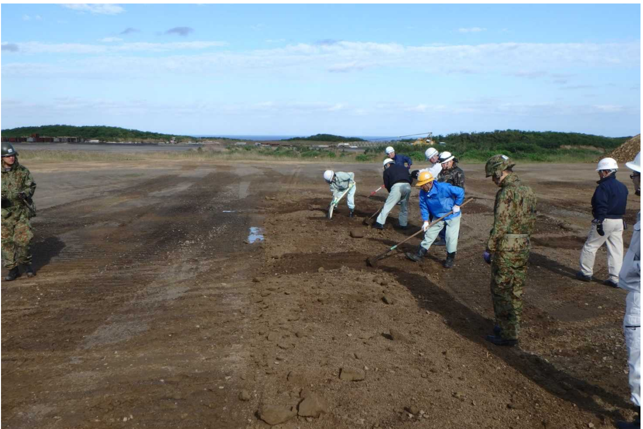
掘削した土砂を仮置き場で確認
