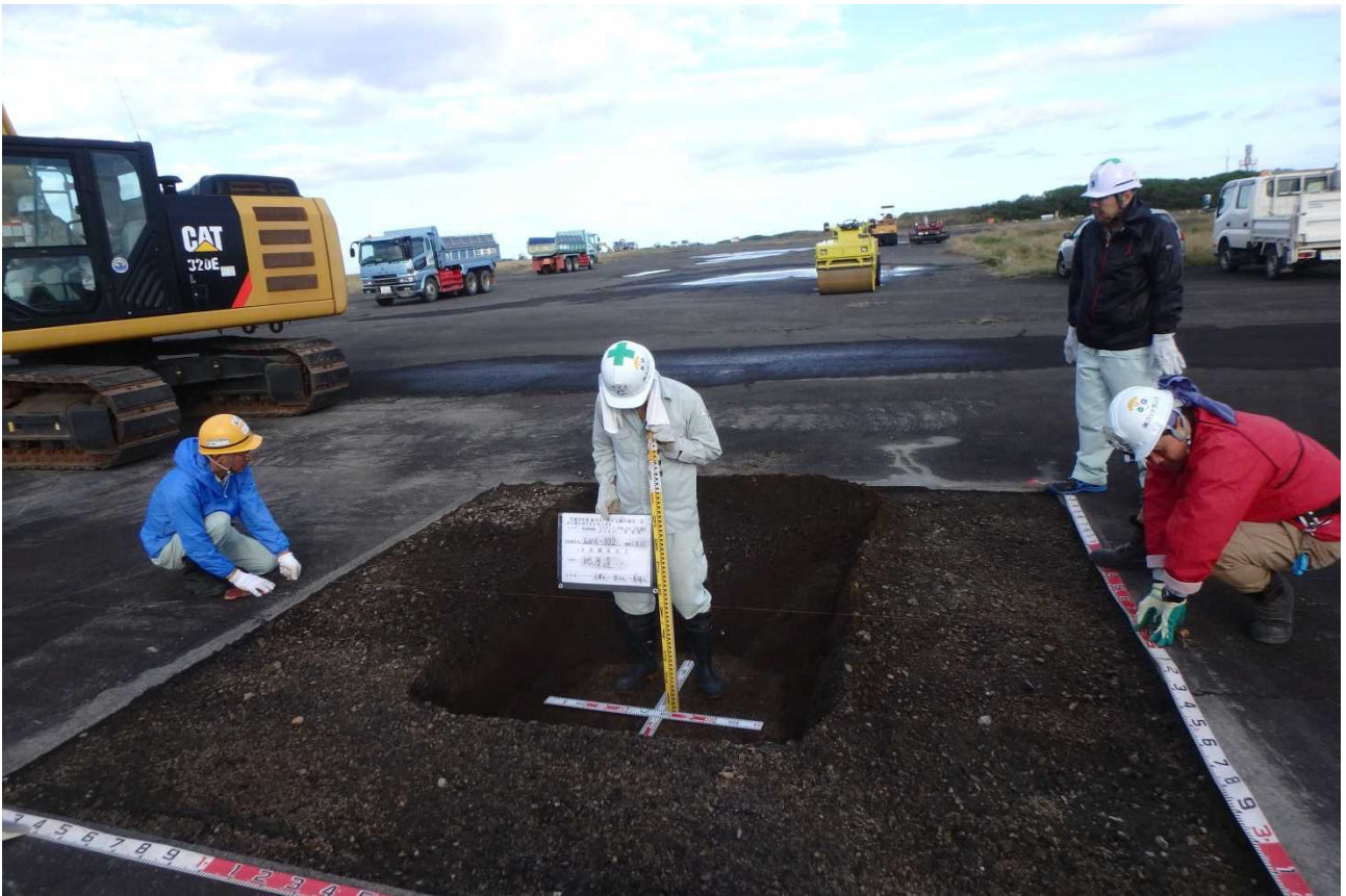
反応箇所の掘削
