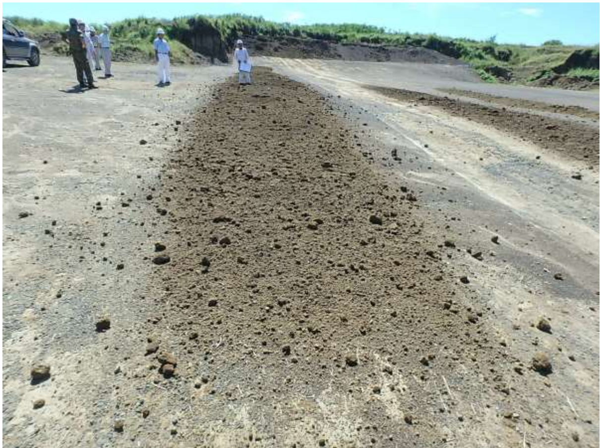
掘削した土砂を仮置き場で確認
