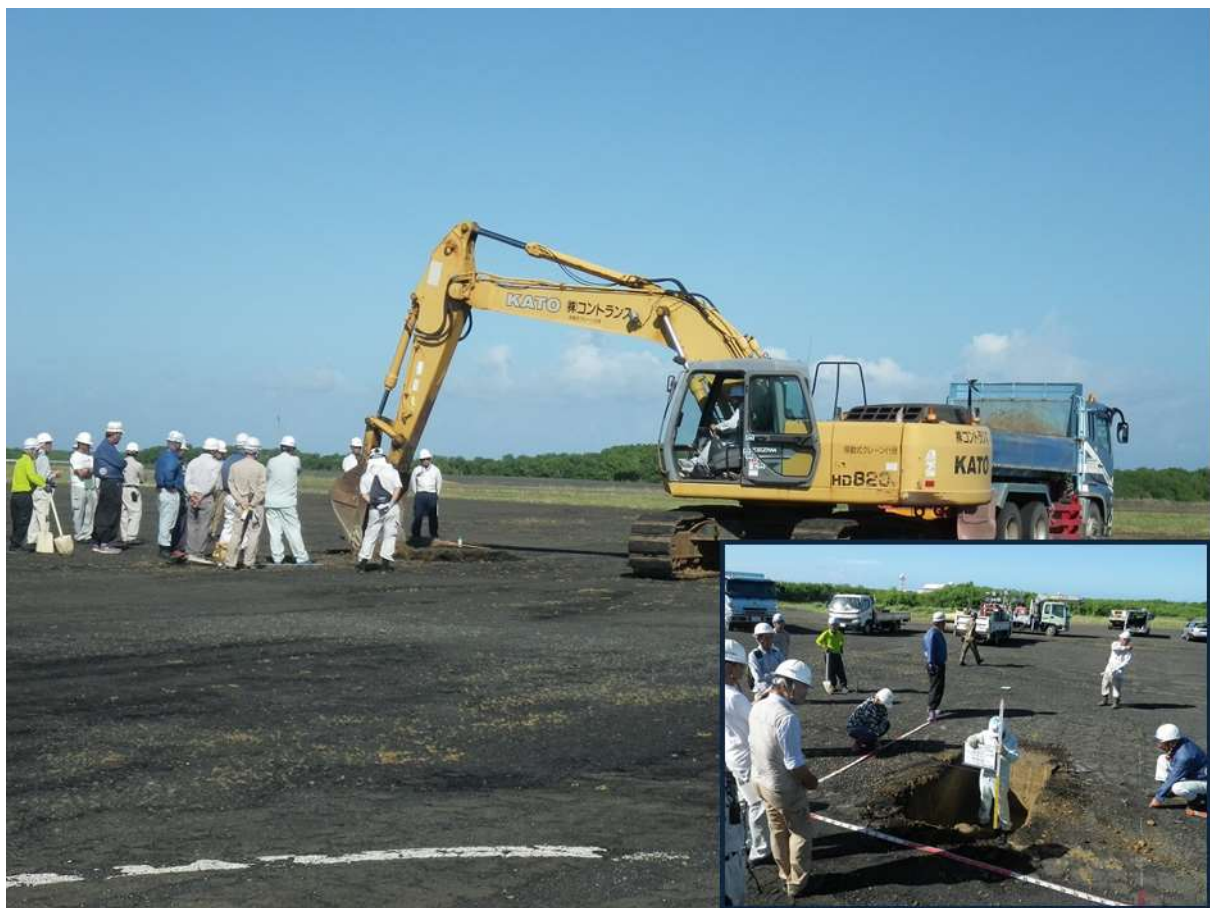
反応箇所の掘削
