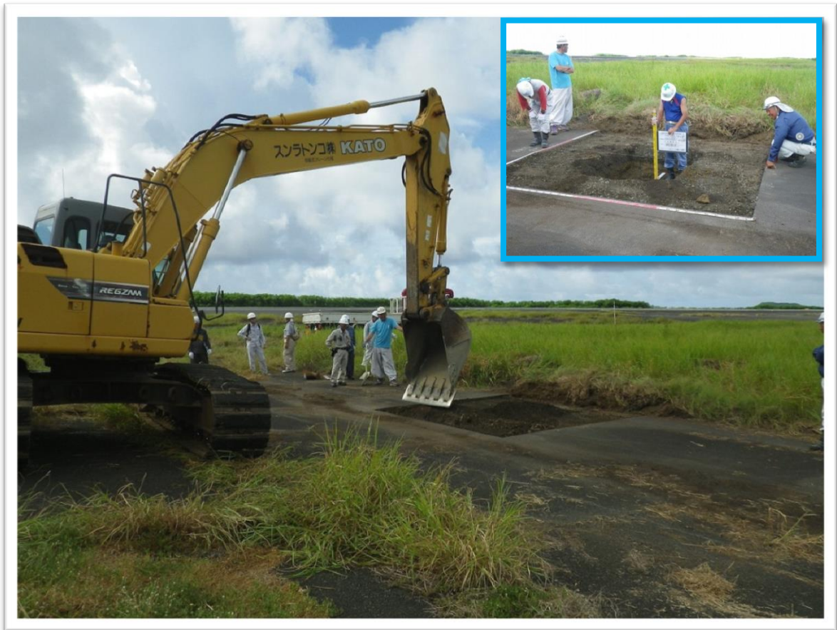
反応箇所の掘削
