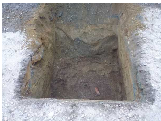
反応箇所の掘削
