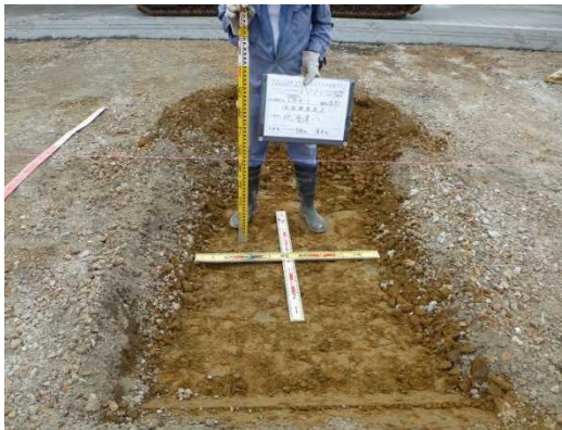
反応箇所の掘削
