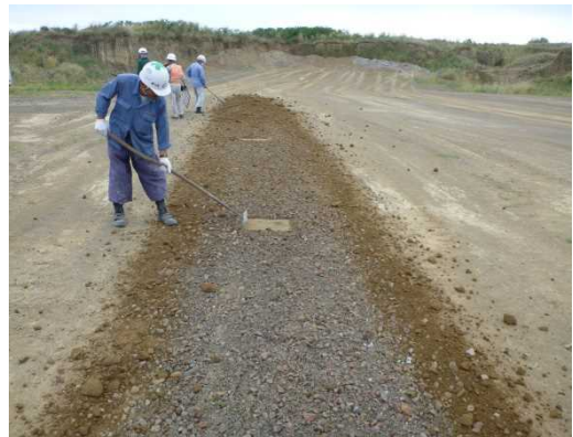
掘削した土砂を仮置き場で確認
