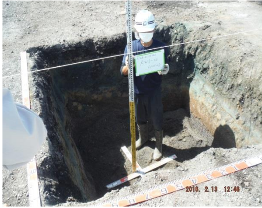
反応箇所の掘削
