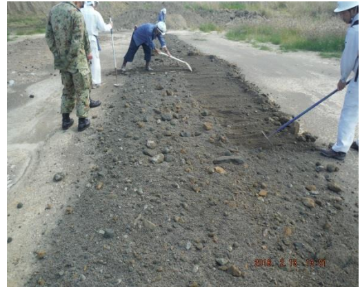
掘削した土砂を仮置き場で確認
