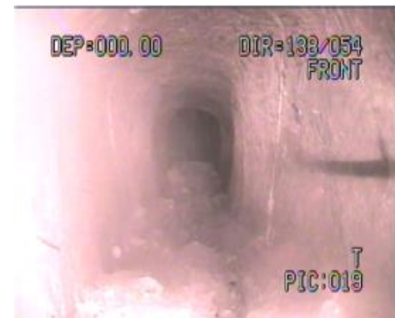
地下壕①の状況
