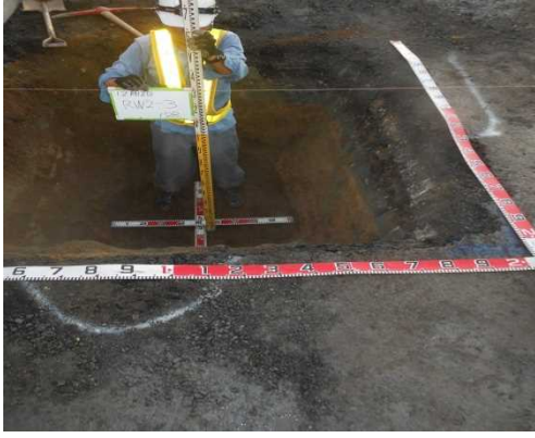
反応箇所の掘削
