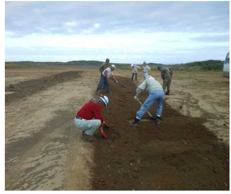
掘削した土砂を仮置き場で確認
