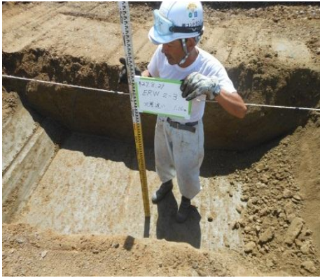
反応箇所の掘削
