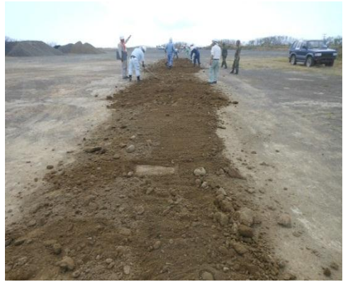
掘削した土砂を仮置き場で確認
